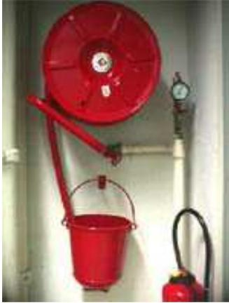
§2 Un manomètre avec robinets à trois voies doit être mis en place près de ce R.I.A. pour permettre le contrôle de cette pression.
